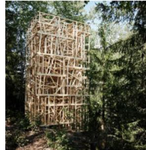
Der Holzturm #Caschlatsch ist ein Paradebeispiel für die Symbiose von Tradition und Innovation, Handwerk und Technologie. Geplant und erstellt wurden die Elemente des Turms im Robotic Fabrication Lab der ETH Zürich in Zusammenarbeit von Mensch und Maschine. Danach wurden die Module nach Disentis in eine Zimmermannwerkstatt transportiert und so weit vorbereitet, dass sie vor Ort zusammengesetzt werden konnten.
